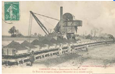
Excavateur à godet et envoi des déblais par chemin de fer
